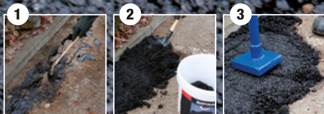
Primer aanbrengen
